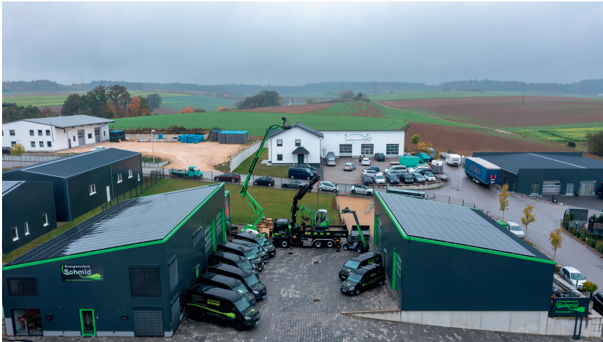
Bild 2: Schon das Firmengebäude zeigt die Ausrichtung des Elektrohandwerksbetriebes auf erneuerbare Energien
