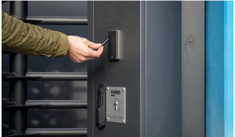
**Bild 2:** Der auf dem Campus verbaute »Paxton10 Slimline Reader« arbeitet mit sicher verschlüsselter Kommunikation
