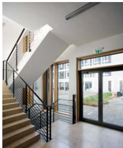
Bild 3: Bei größeren Gebäudekomplexen kann oft nur über die Treppenhäuser evakuiert werden, der Türschließer muss daher störungsfrei funktionieren
