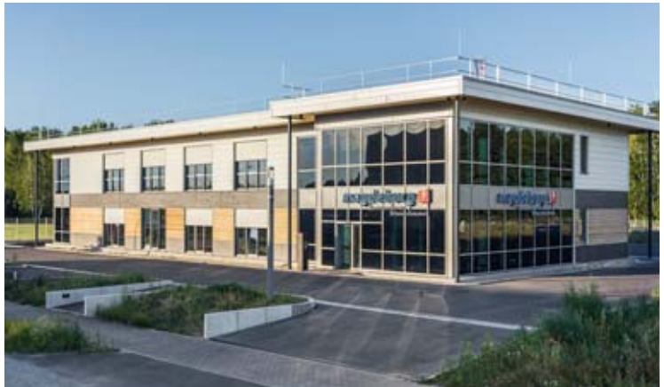
Bild 3: Das neue Firmengebäude ist das Wahrzeichen für Kompetenz, Innovation und Zuverlässigkeit des Elektrohandwerksbetriebes Magdeburg Gruppe
