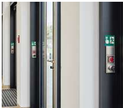
Bild 3: Elektronischer Zylinder als Mechanik-Ersatz: Hier in den Schlüsselschaltern eines Fluchtwegsicherungssystems – und natürlich an den Außentüren.
