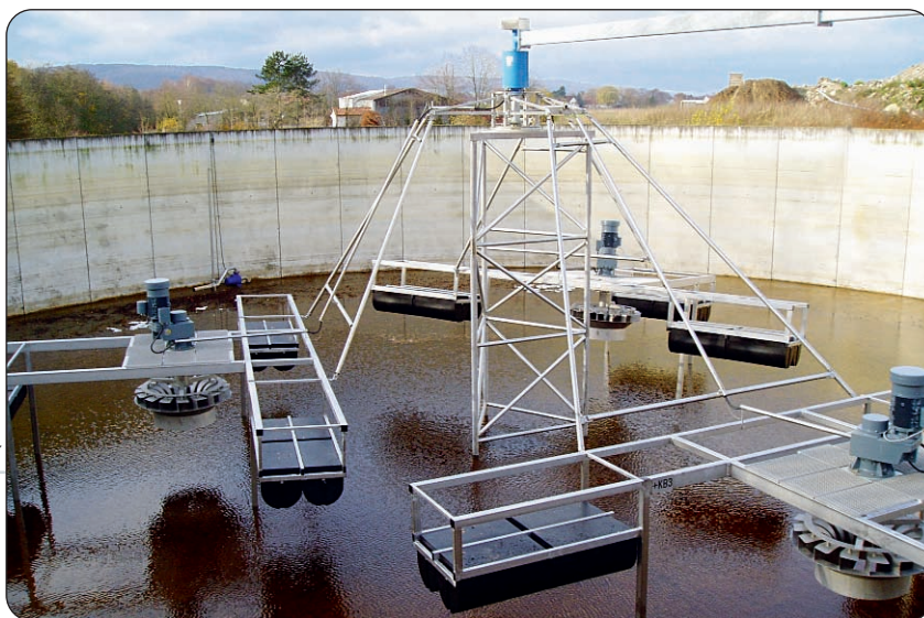
Bild 1: Beim Bau der Kläranlage in Bad Essen Wittlage wurde der Batch-Reaktor (MSBR – Multifunctional Sequencing Batch Reactor) mit drei Oberflächenbelüftern zur Eintragung von Sauerstoff ausgestattet
