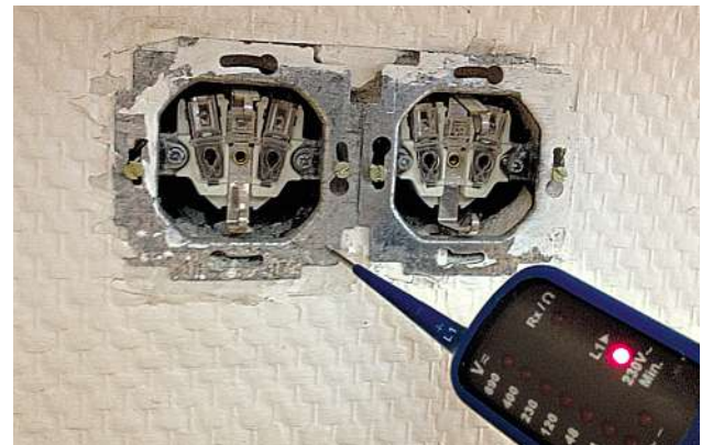
Bild 1: Gefährliche Berührungsspannung am Metallring einer Steckdose
